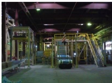
단열 설비 공장
